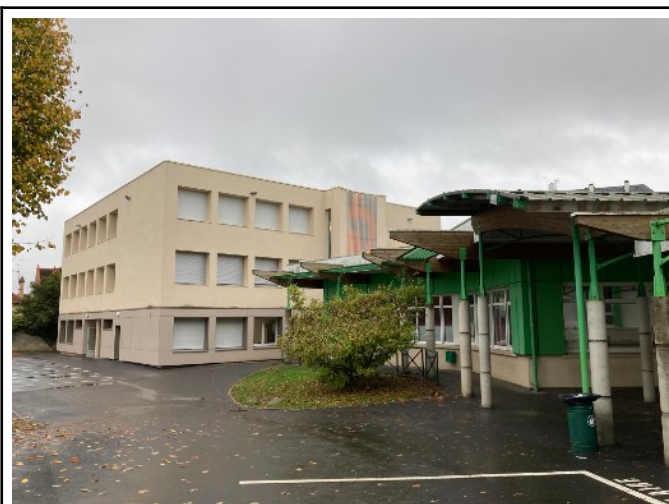
Extension en retrait de la rue : Pierre Auvray et Jean-Marie Chevalier réalisée en 1978
